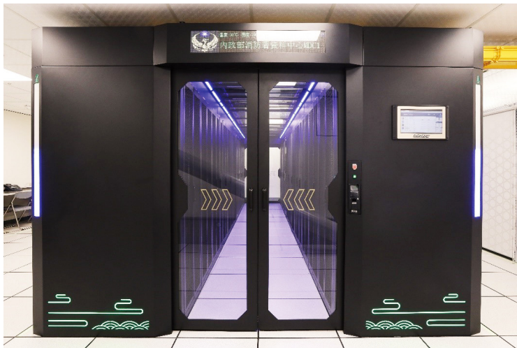
圖 4-9-7 冷熱通道封閉系統
