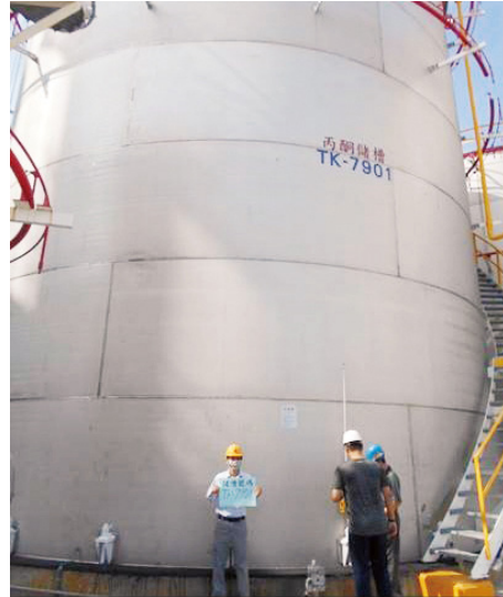
圖 4-3-1 公共危險物品儲槽檢查情形
