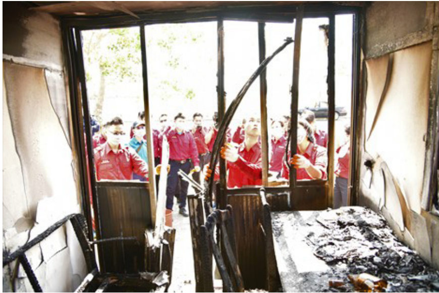
圖 4-6-3 火災原因調查鑑定訓練班學員勘察燃燒現場
