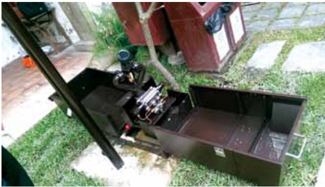
■孔廟地上型放水槍內部結構。
