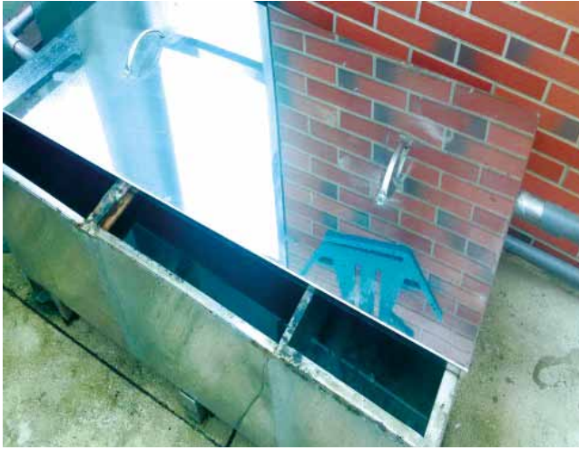
■洗衣用水回收系統及節水儲槽。
