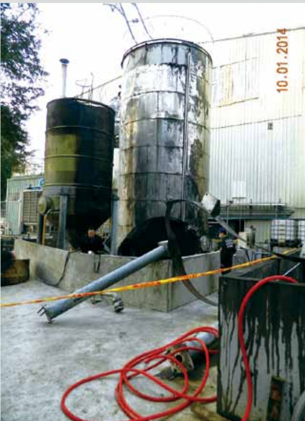
■儲槽因歲修焊接不慎，造成爆炸。(資料來源：消防署拍攝)
