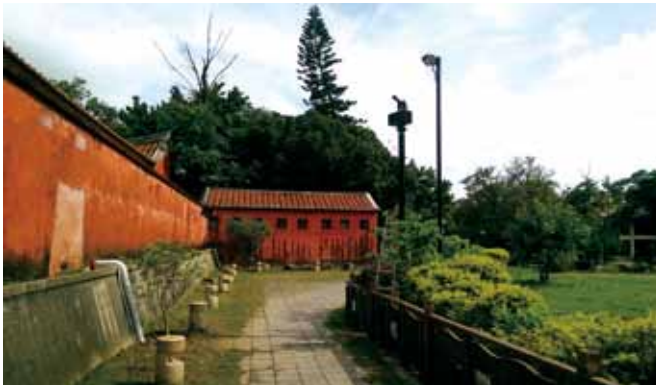
■孔廟高架型放水槍設置位置。
