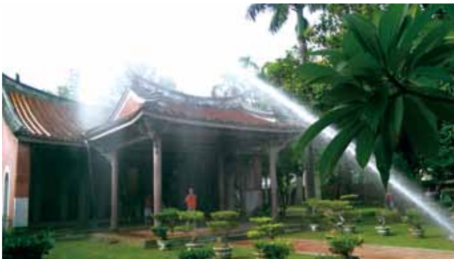
■孔廟明倫堂地上型放水槍防護測試。
