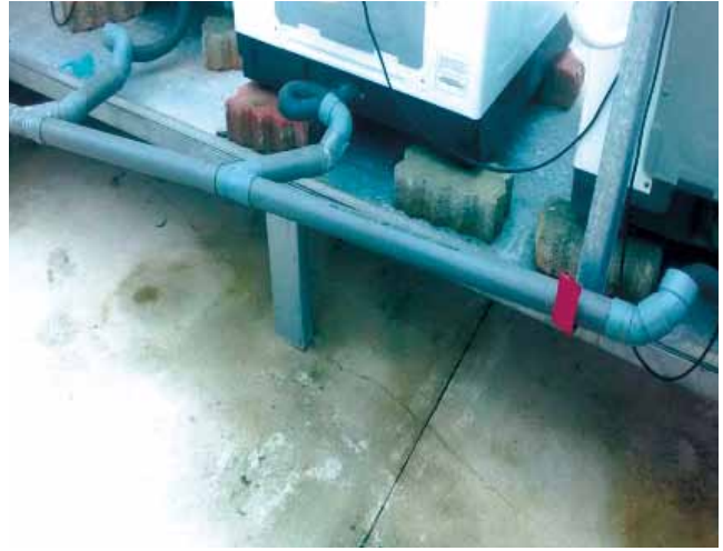
■洗衣用水回收系統及節水儲槽。
