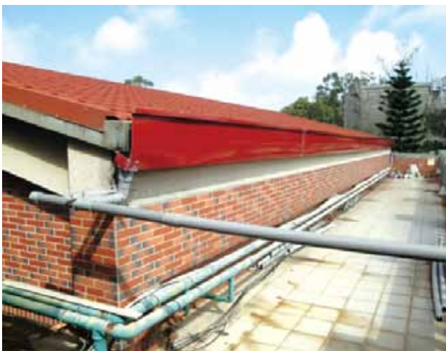
■屋頂設置雨水回收系統。
