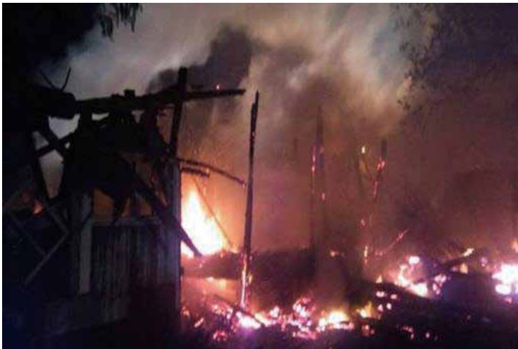
■建於日據時代的北港糖廠廠長宿舍大火。
