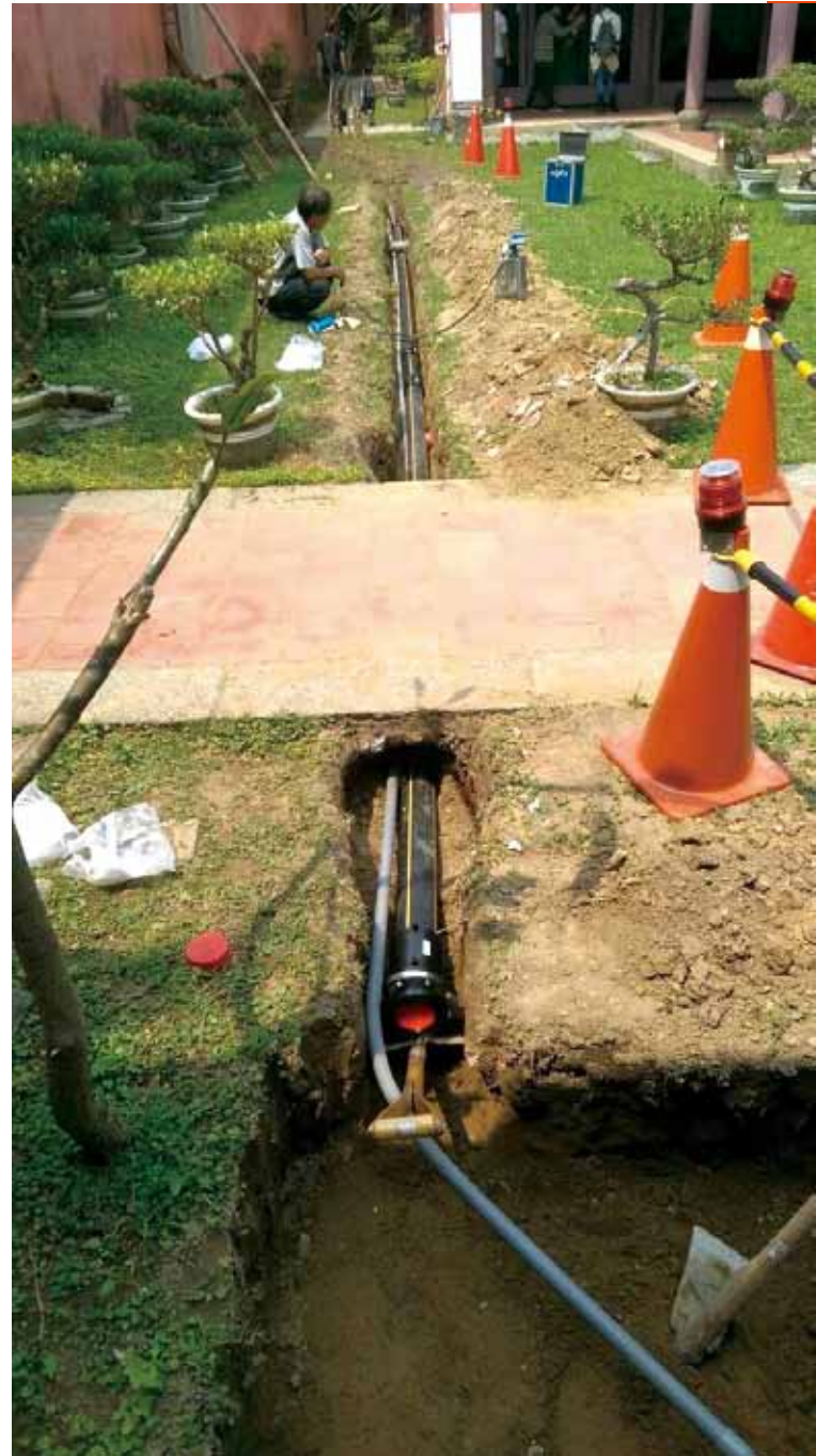
■孔廟水系統管路施工情形。
